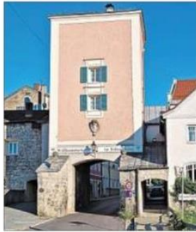
Die beiden Stadttore, hier das Burghausener Tor im Norden, sollen noch heuer saniert werden.
