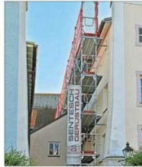
Gerüste gehören aktuell zum Stadtplatzbild: Derzeit wird die Fassade des „Braugasthofes“ saniert.
